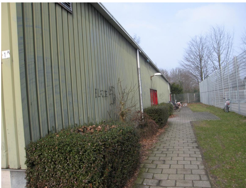
Foto 8. De oostzijde van de te slopen tafeltennishal.
