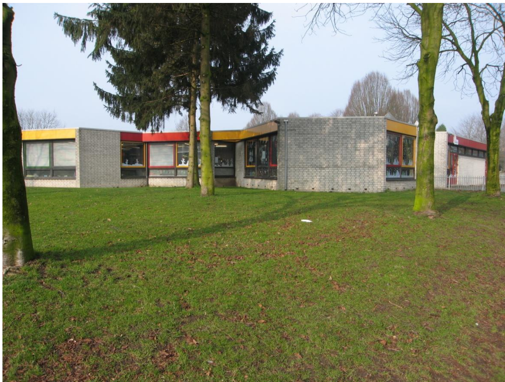
Foto 7. Een van de twee te slopen basisscholen.
