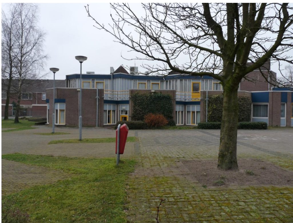
Foto 5. Bebouwing van het te slopen wijkcentrum.
