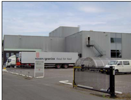
Afbeelding 11. Zicht op recyclingsfabriek en kantoren
