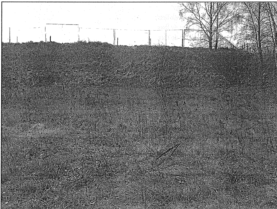
foto 1 hoogteverschillen in het terrein
