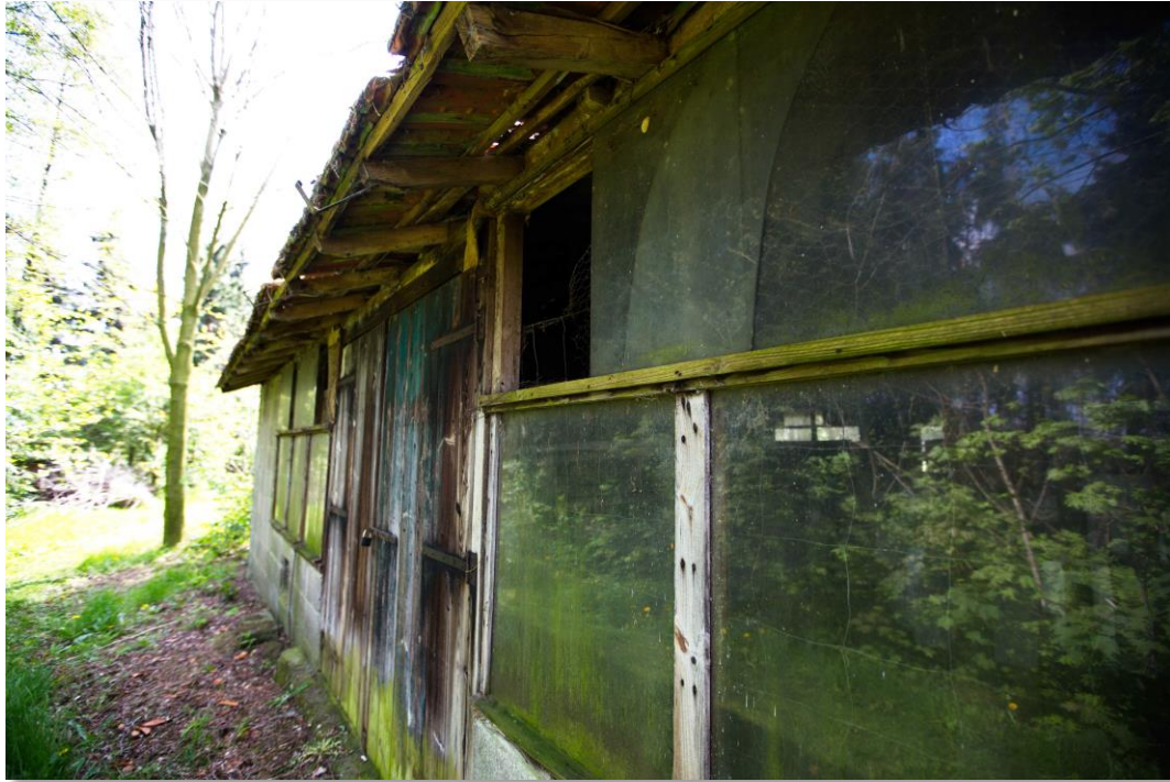
Figuur 5a: Stenen kippenschuur in bosje
