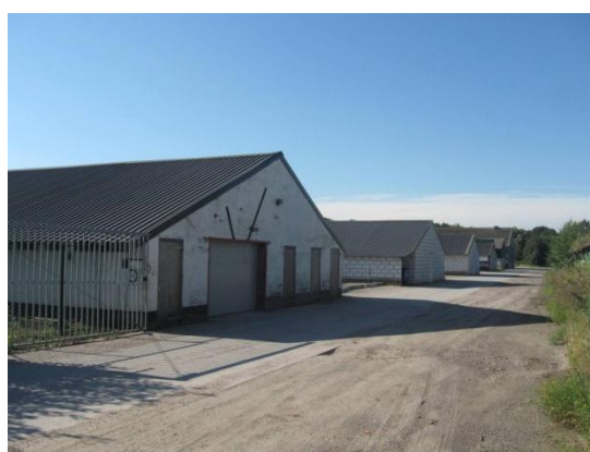
Foto 2. De loodsen/stallen op het terrein, vanaf de westgrens van het perceel in zuidelijke richting gezien.
