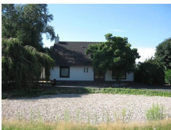
Foto 1. De woning, vanaf de Blakterweg in zuidelijke richting gezien.
