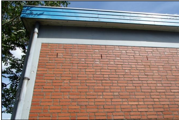
Figuur 9. open stootvoegen
