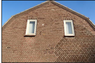
Figuur 10. Kopse kant woonhuis.
