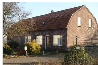
Figuur 8. Te slopen woonhuis.
