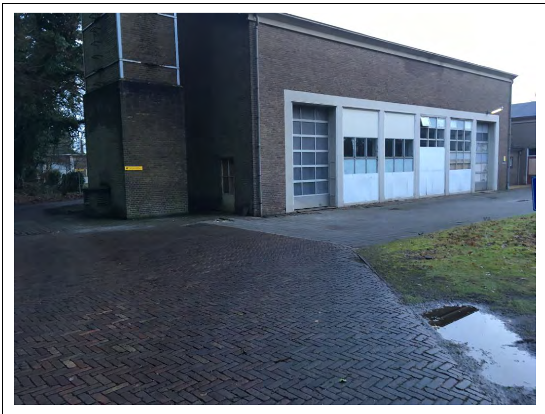
Foto 4. Locatie voormalige ondergrondse brandstoftank naast ketelhuis
