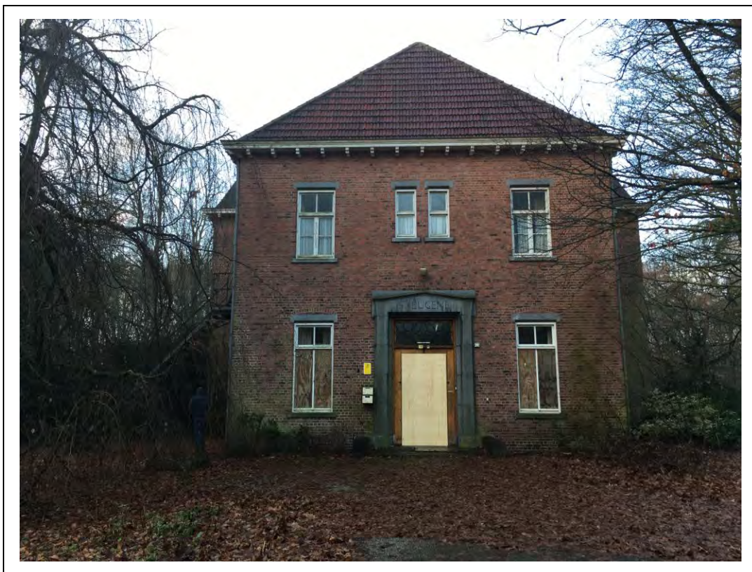
Foto 18. Gebouw brand december 2016
