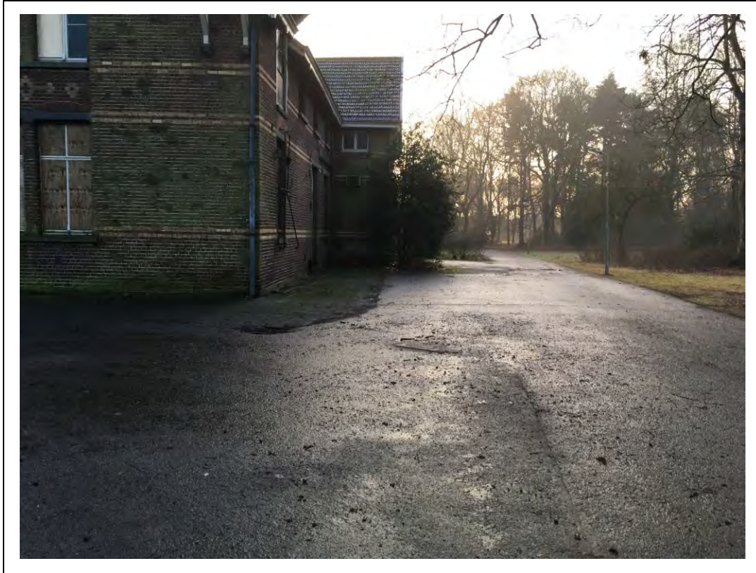
Foto 17. Voormalige tank noordzijde hoofdgebouw
