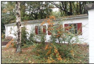
Figuur 3. Zuidzijde van de te slopen bebouwing
