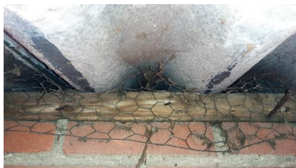
Figuur 7. De ruimten onder de ‘golven’ van de asbest daken zijn deels opgevuld of dichtgemaakt met gaas; hier is geen ruimte voor vogelnesten of vleermuisverblijven.
