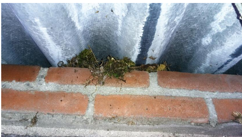
Figuur 8. De ruimten onder de ‘golven’ van de asbest daken zijn deels open; hier is ruimte voor vogelnesten. Op de foto is een oud nest te zien van winterkoning/roodborst. Voor vleermuisverblijven zijn deze ruimten te tochtig.
