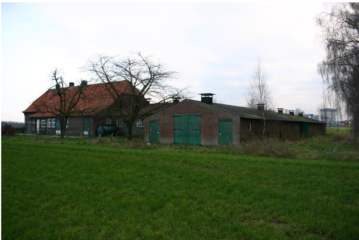
Figuur 5. Enkele hoogstam-appelbomen met daarachter het woonhuis en rechts de vervallen grupstal.
