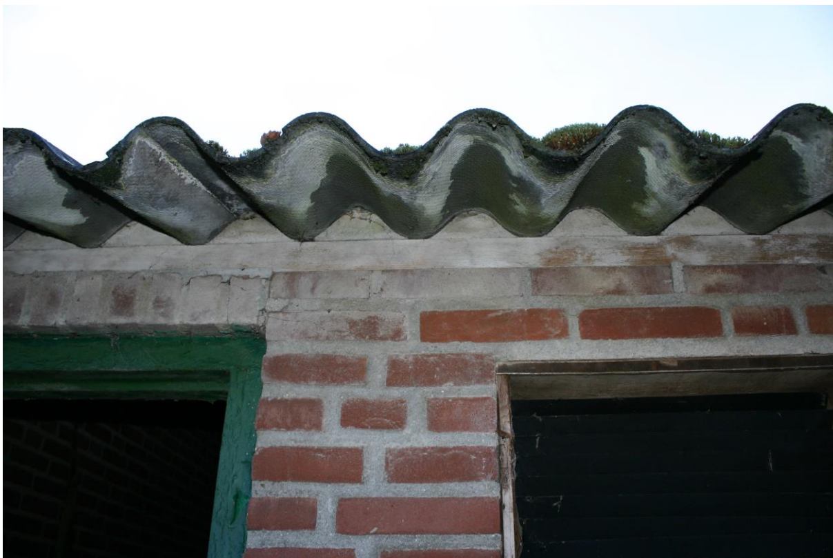
Figuur 8. Onder de golven van het eternieten dak zijn geen openingen aanwezig.
