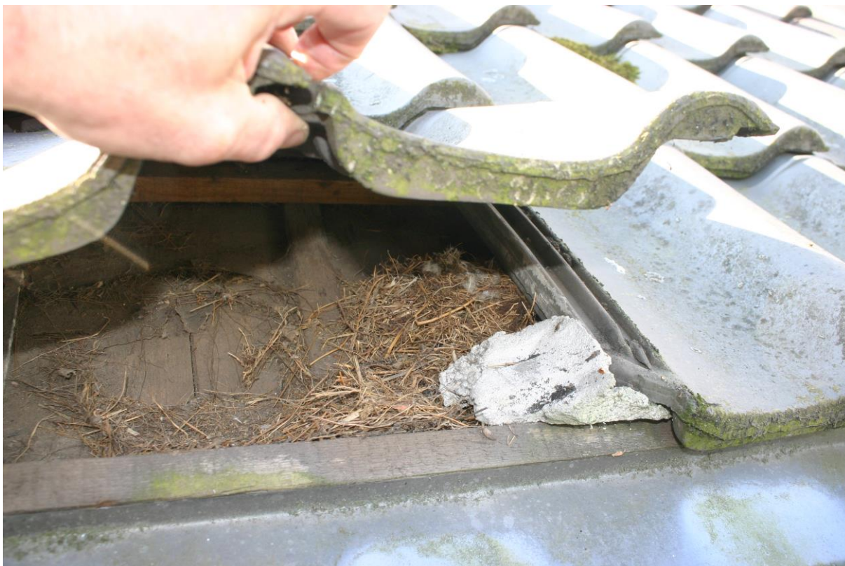
Figuur 4.2.1. Onder de onderste rij dakpannen bevindt zich een oud huismussennest. Er is geen nestkom meer aanwezig.
