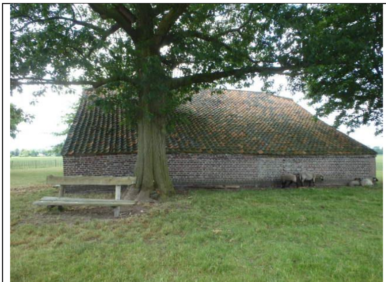
foto 1: schaapskooi gezien vanuit het oosten (30 mei 2018)
