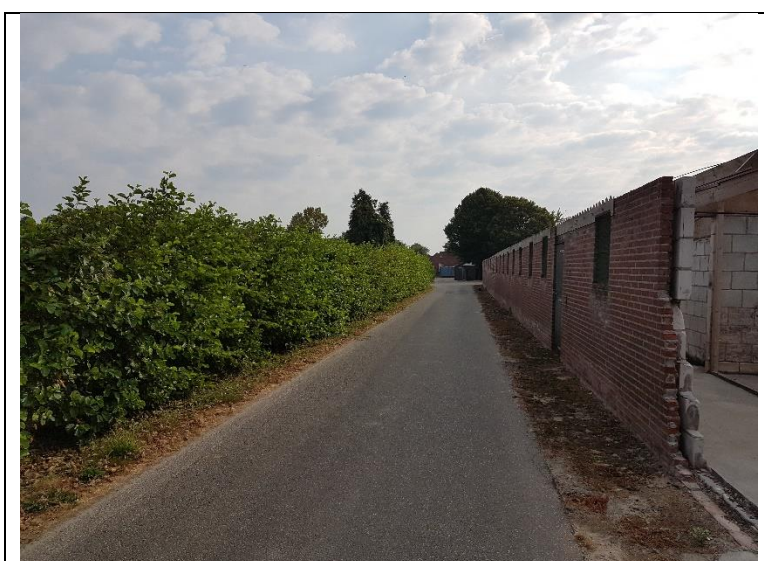
foto 3: geasfalteerde weg noordelijke terreindeel Zandhoek 13 gezien vanuit het zuidwesten (19 juli 2018)
