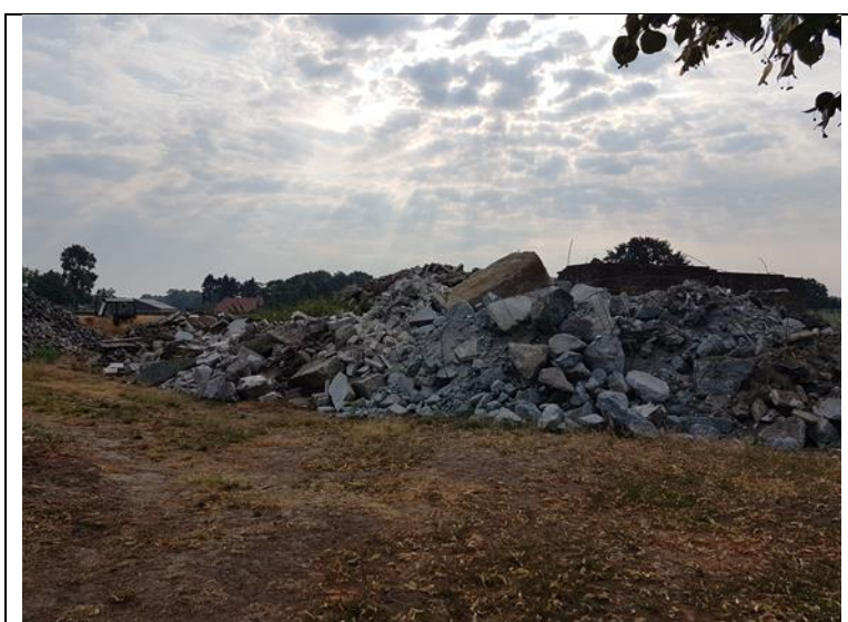
foto 2: puindepot op zuidoostelijk deel onderzoekslocatie gezien vanuit het noorden (19 juli 2018)
