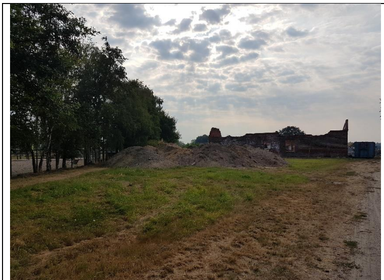
foto 1: gronddepots op noordwestelijke deel onderzoekslocatie gezien vanuit het westen (19 juli 2018)
