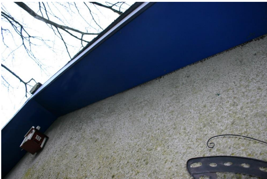
Figuur 4.2.1. De windveer sluit nauw op de gevel aan.
