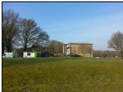
Figuur 3. Bebouwing drinkwaterinstallatie vanuit westelijke hoek.
