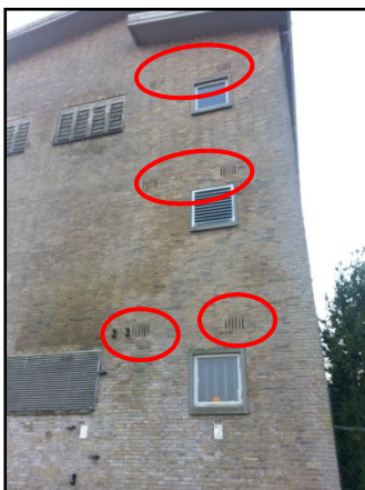
Figuur 15. Open stootvoegen die toegang verlenen tot de spouwmuur.
