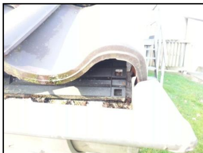
Figuur 12. Plastic afscherming onder eerste rij dakpannen.
