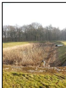
Figuur 7. Wateropvang oostelijk deel drinkwaterinstallatie.
