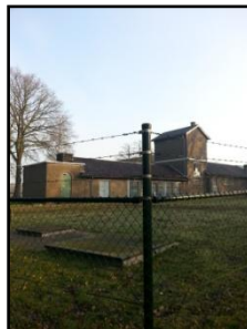
Figuur 4. Bebouwing drinkwaterinstallatie vanuit zuidoostelijke hoek.
