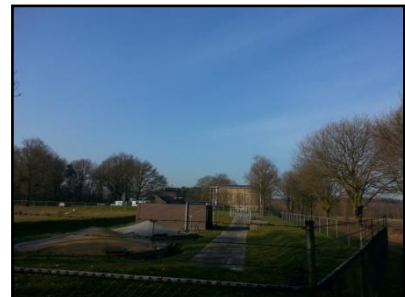
Figuur 5. Bebouwing drinkwaterinstallatie vanuit westelijke hoek.
