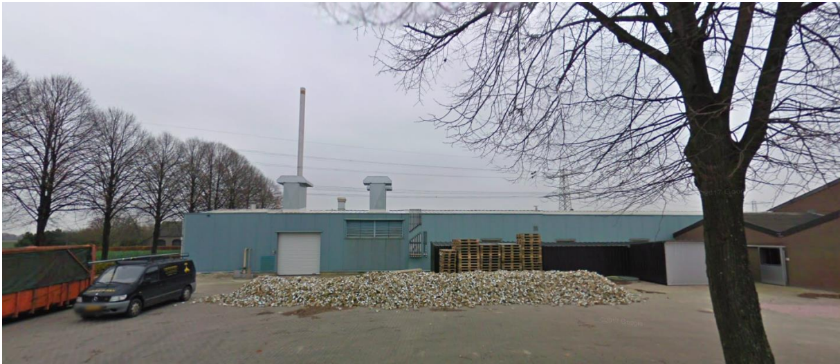
Huidige WKK en ketelinstallatie binnen bedrijf
