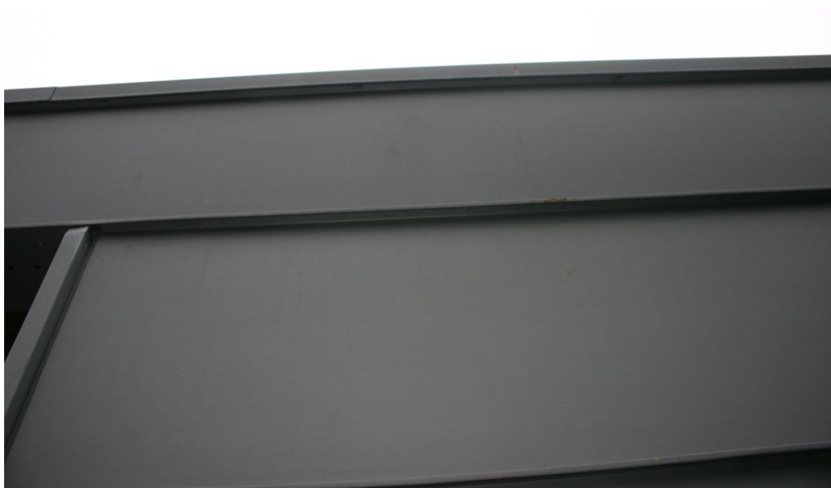
Figuur 4.2. In de (gevel aan de noordzijde van de) bestaande bebouwing bevinden zich geen openingen waardoor vleermuizen naar binnen kunnen.
