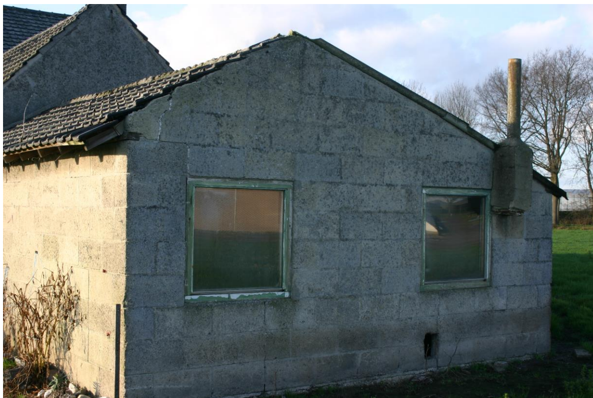
Figuur 4.2.1. Onder de gevelpannen aan de achterzijde van de aanbouw (Scheiweg) bevinden zich enkele kleine openingen die toegankelijk zijn voor vleermuizen.
