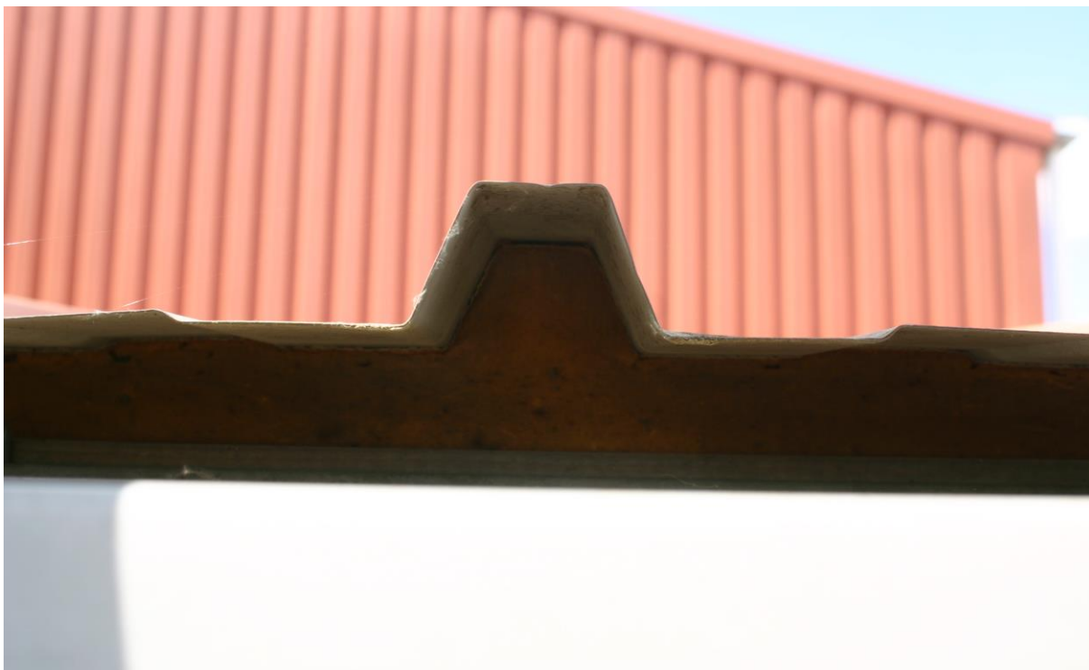
Figuur 4.2.5. De ruimte onder de damwand daken van beide loodsen is volledig afgedicht.
