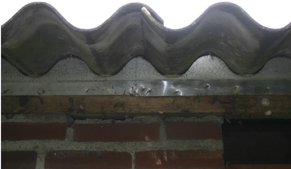
Figuur 4.2.3. De ruimte onder de ‘golven’ is afgedicht met hardboard vogelschroot. De stallen zijn dus ongeschikt als nestplaats voor huismussen.
