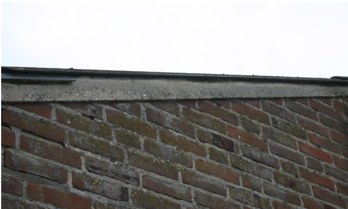
Figuur 4.2.1. De ruimte tussen de golfplaten en de spouw op de kopse kant van één varkensstal is afgedicht met specie en daardoor niet bereikbaar voor vleermuizen.
