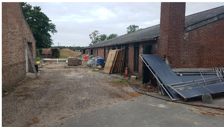
Foto 1: Schuur en achterzijde boerderij, dakgoot aan de golfplaten (12 juni 2020)
