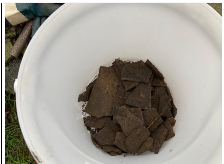
Foto 5: aangetroffen asbest proefsleuf 3 (23 december 2020)
