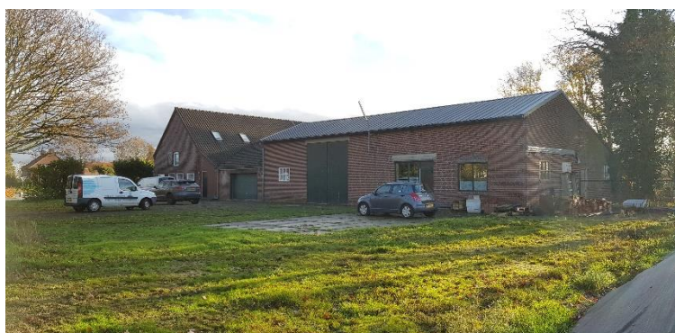
Foto 1: noordzijde bebouwing Hoofdstraat 2 (4 december 2020)
