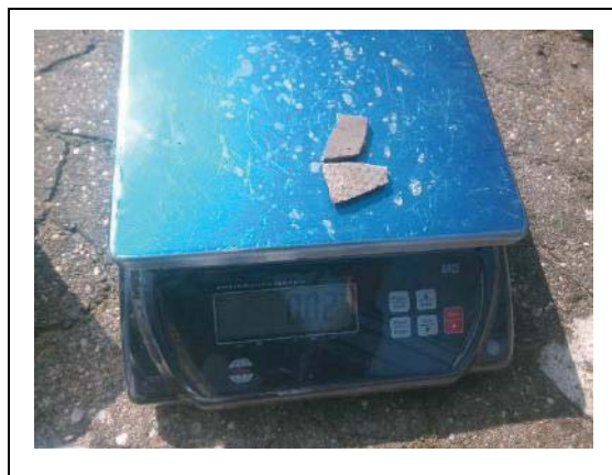
Asbestverdacht plaatmateriaal gat A14
