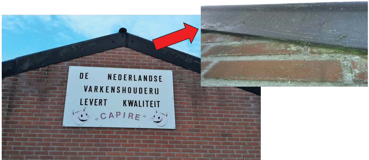
Figuur 10. Onder de windveren is geen ruimte voor vleermuisverblijven.
