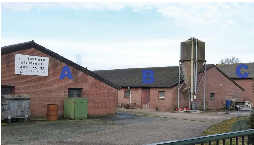
Figuur 7. De drie varkensstallen (A, B en C) in het noordelijk deel van het plangebied.
