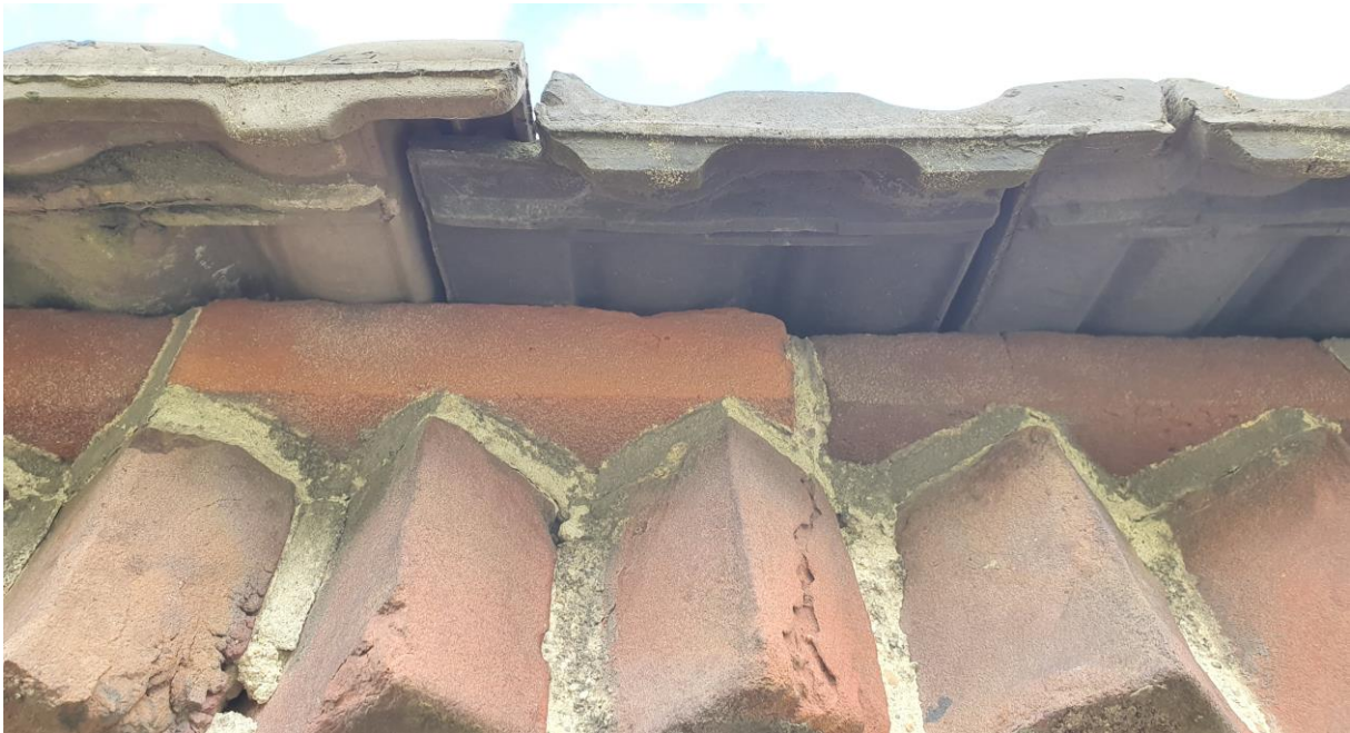
Figuur 4.2.1. De dakpannen sluiten nauw aan op de bakstenen. Vogels hebben hierdoor geen toegang. Vleermuizen zouden wel via de spleten bij de ruimte tussen het dak en het dakbeschot kunnen komen.
