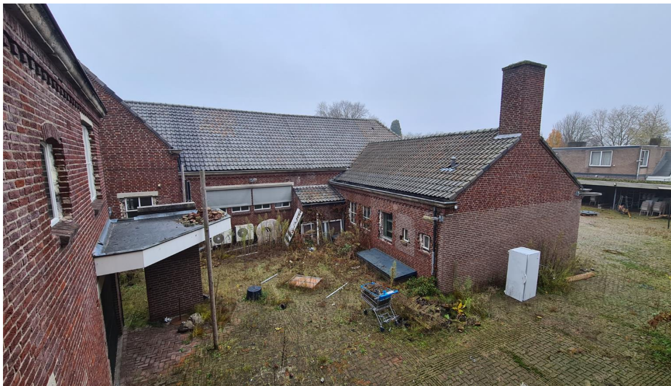
Figuur 4: Binnenplaats postkantoor
