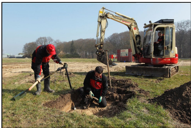
Figuur 8. Benaderen van een significant object m.b.v. een hydraulische graafmachine.
