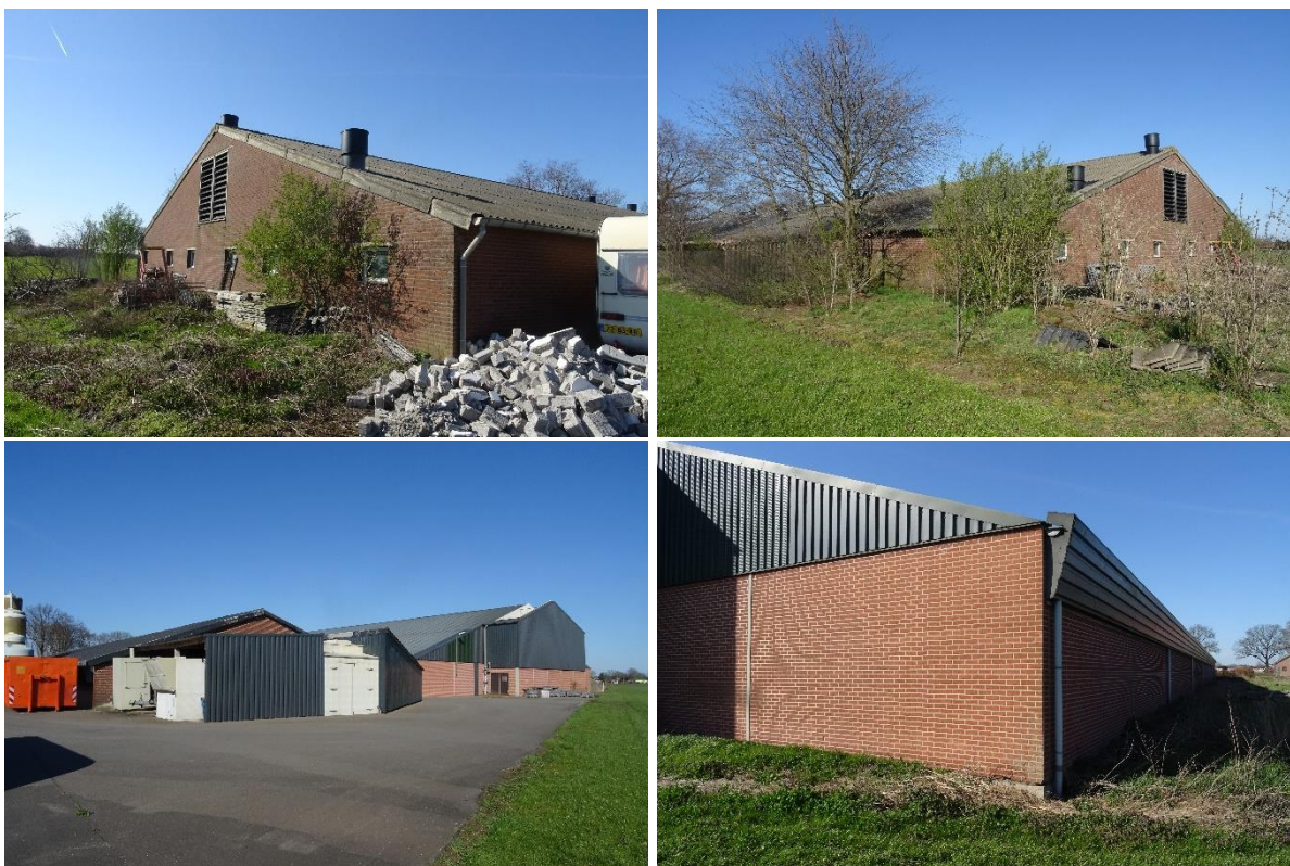
Afbeelding 3 t/m 6: Te slopen varkensstallen, welke bezocht en onderzocht zijn op de aanwezigheid van beschermde soorten flora en fauna. Bron: Rik Bijvelds, datum: 29-03-2021
