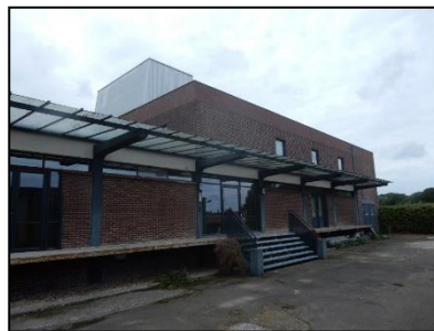
Figuur 4. Indrukken plangebied. Kantoorpand. Kijkrichting westelijk.
