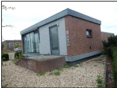
Figuur 9. Indrukken plangebied. Kantoorgebouwtje. Kijkrichting noordwestelijk.
