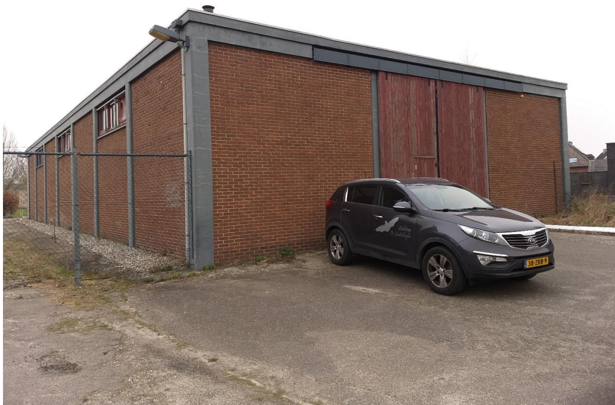
Voorzijde gebouw, zuid kant
