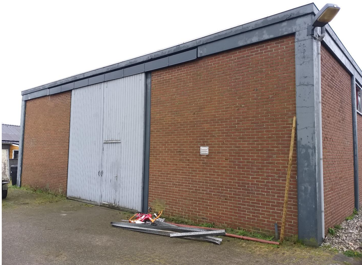
Achterzijde gebouw, noord kant
