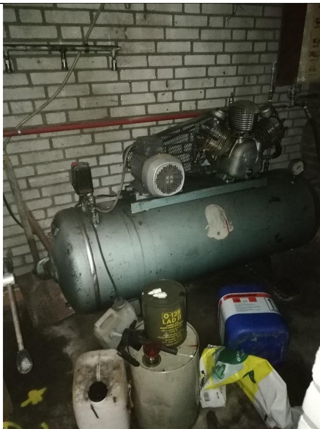
Foto 6: olieopslag deellocatie D (22 februari 2021)
