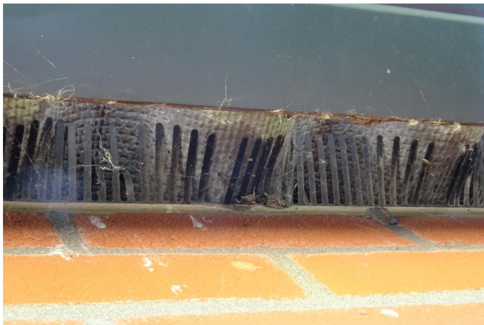
Afbeelding 13: Daken stallen afgesloten met vogelschroot. Bron: R.J.L. Bijvelds 07-06-2021
