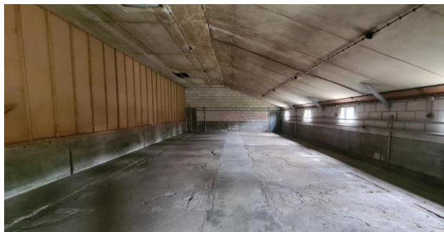
Figuur 8: Binnenkant te slopen schuur
