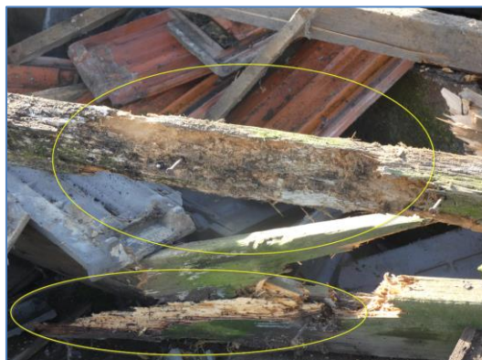
Foto 12 en 13 reeds langer verrotte constructie-delen
