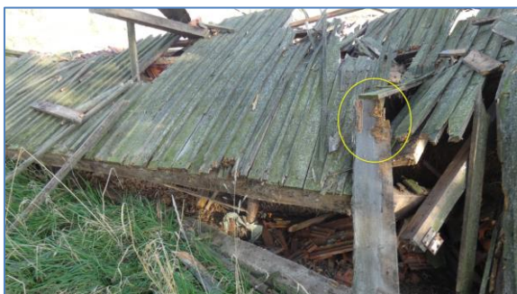
Foto 14 en 15 reeds langer verrotte constructie-delen
