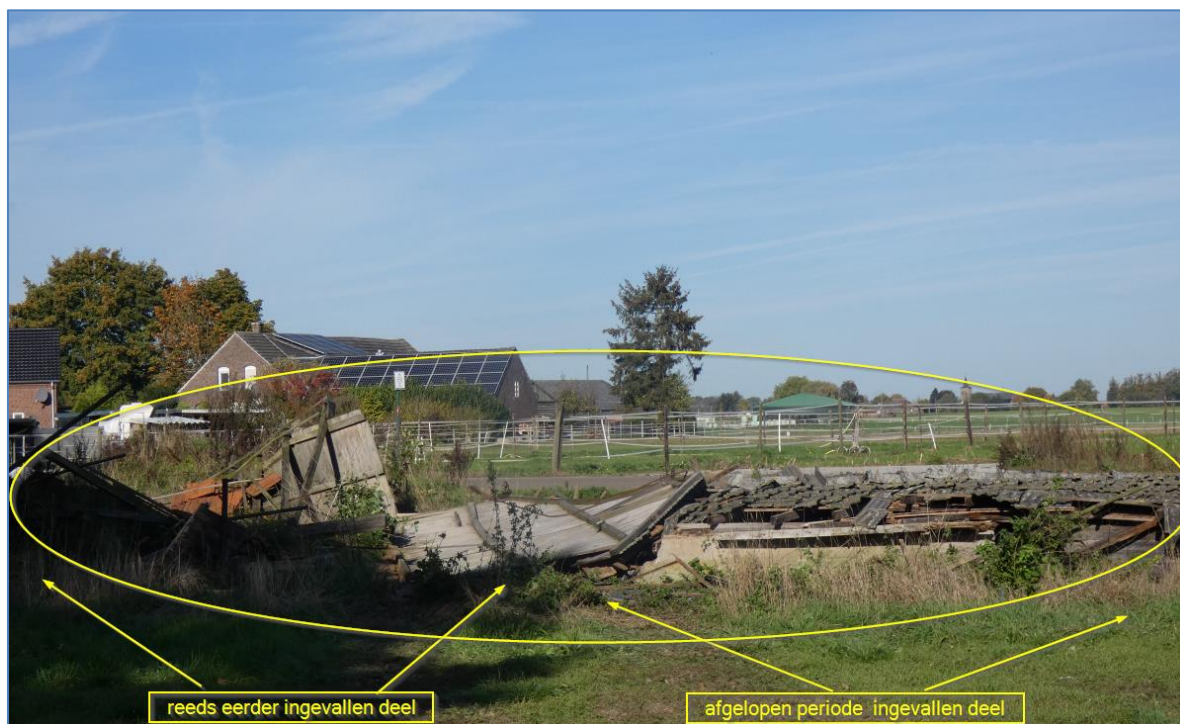
Foto 11 Ingevalle schuurtje met rechts het enkele pannendak zonder onder-beplanking.
