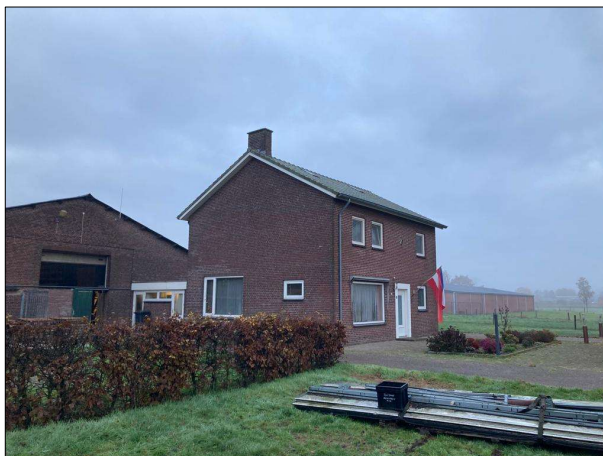
• Afbeelding 3: te slopen woonhuis
