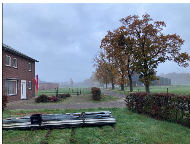
• Afbeelding 6: Voortuin te slopen woonhuis
