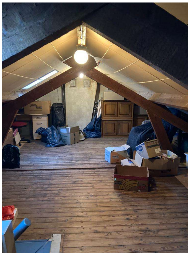
• Afbeelding 5: Zolder te slopen woonhuis
