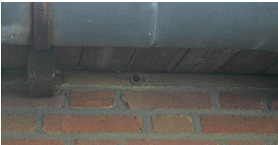
Figuur 4.4.5. Een muurplaat op de lange gevels voorkomt voor vleermuizen toegang tot de spouw.
