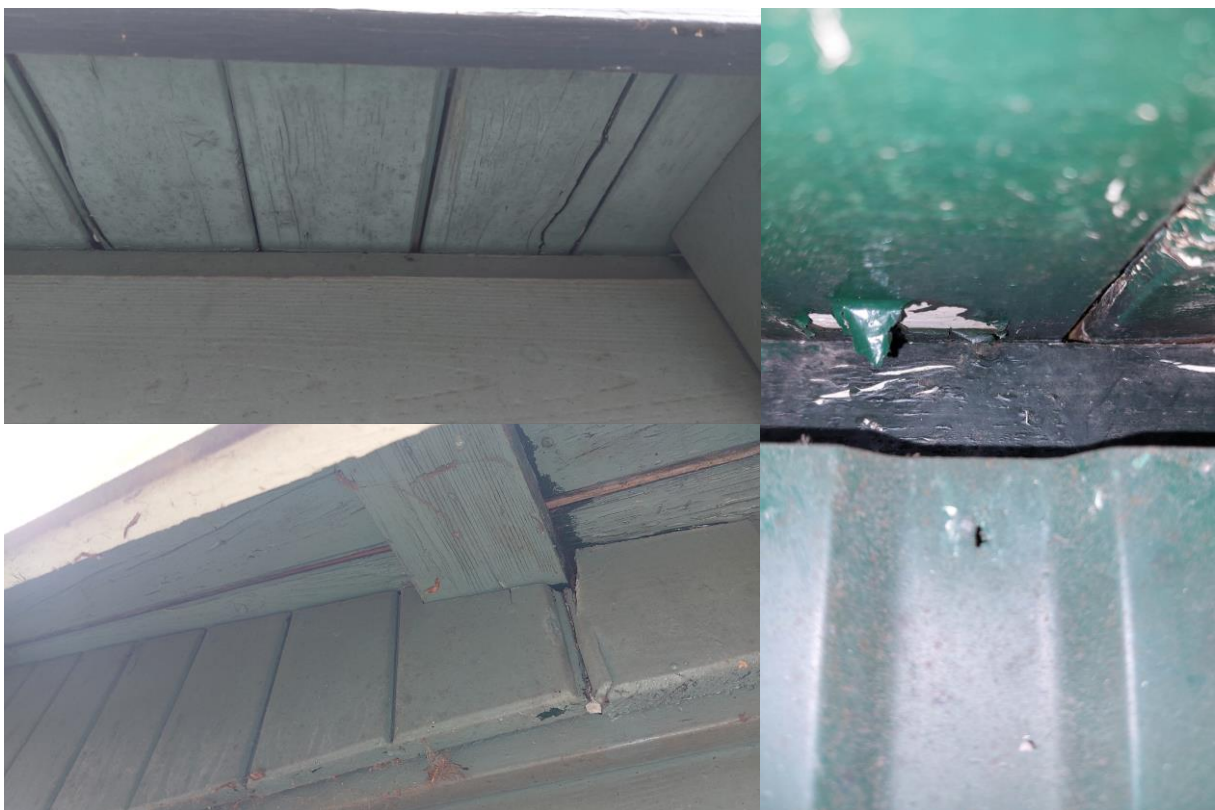
Figuur 4.2.2. Spleten of kieren die toegang kunnen verlenen aan vleermuizen zijn afwezig.
