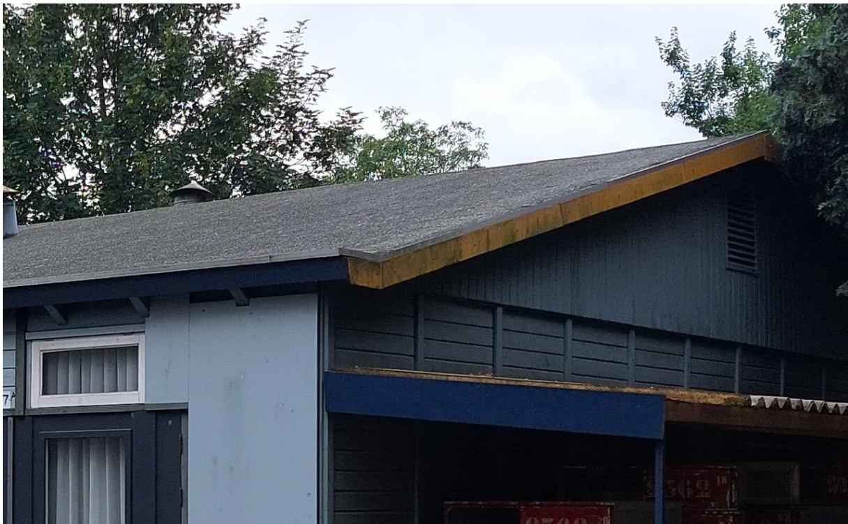
Figuur 4.2.1. Broedlocaties voor de huismus of gierzwaluw zijn in het dak van het gebouw afwezig.
