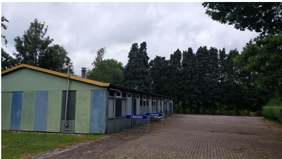
Figuur 4.1.5. F4: Het te slopen gebouw met verharding en zicht op de rij thuja's.
