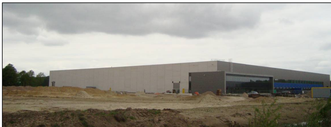
Figuur 1.3: de huidige bedrijfsbebouwing op het perceel Edisonstraat nummers 2 tot en met 6, gezien in noordwestelijke richting
