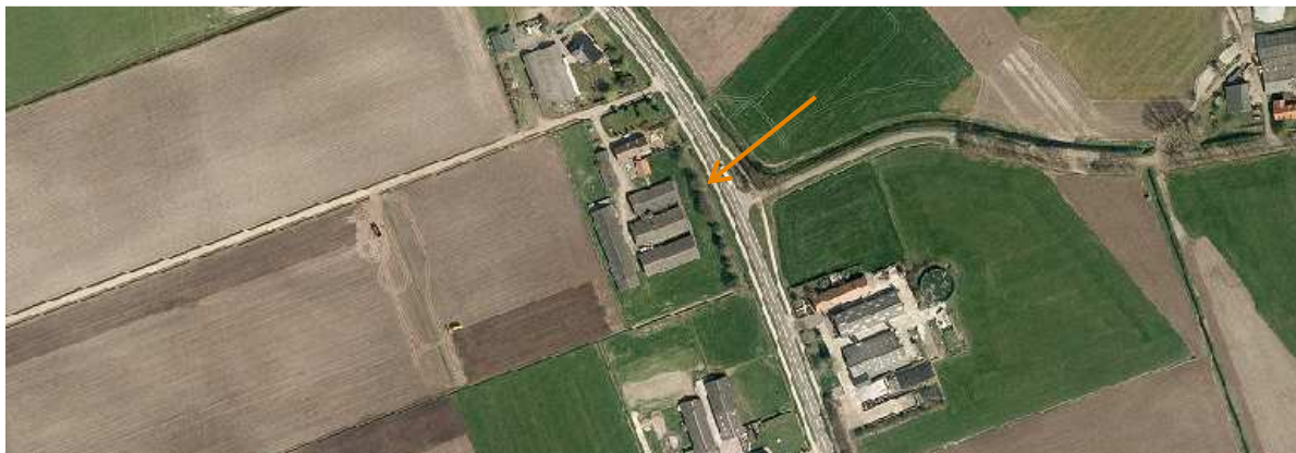
Figuur 3.3.1: Luchtfoto huidige situatie begin 2013
