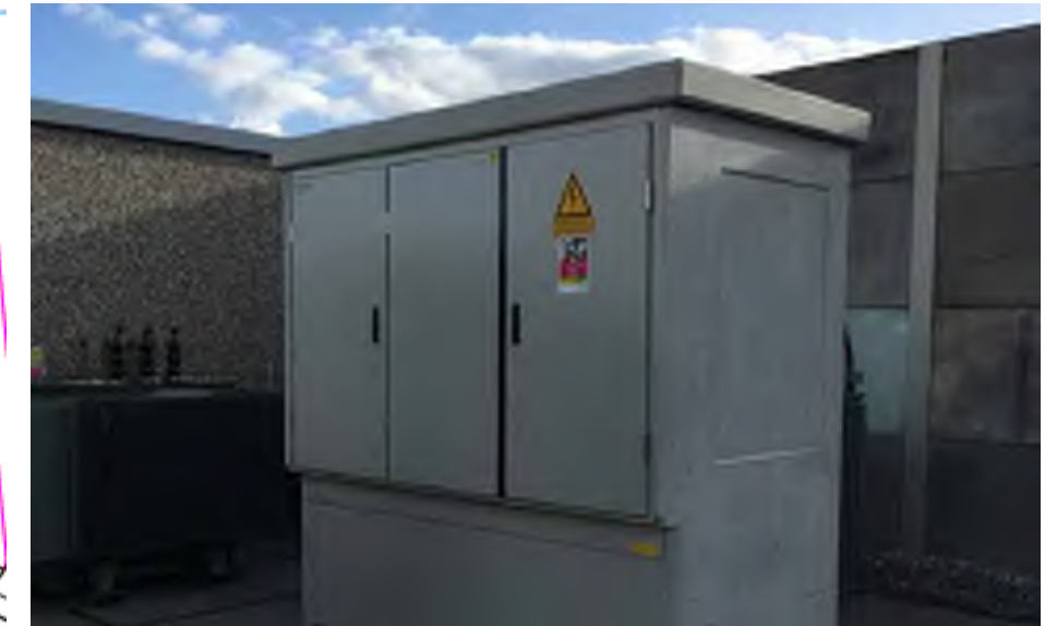
Referentiebeeld inkoopstation Enexis (HV-Utility connection). De bovengrondse maten betreffen 2,33 x 1,25 x 2,02 m (lxbxh). Het inkoopstation wordt uitgevoerd in de kleur antraciet (RAL 7016).
