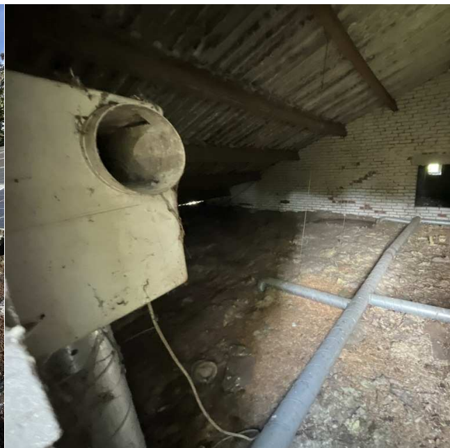
Onderzijde dak, bovenzijde plafonds
