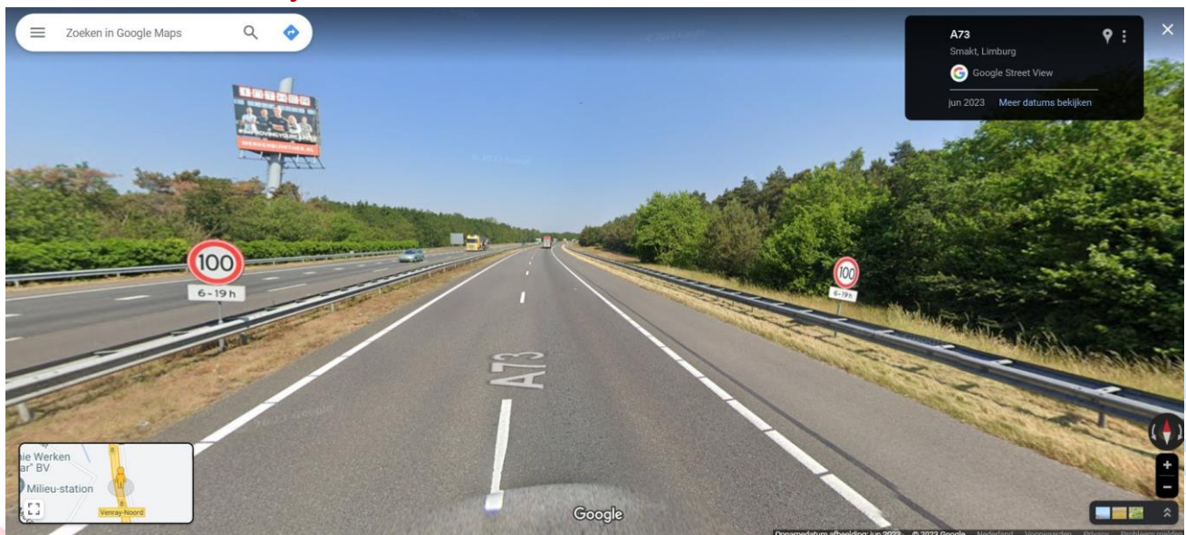
Figuur 4: Streetview A-zijde ( Google streetview )
