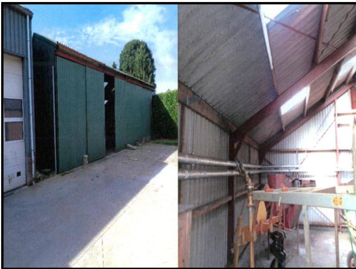
Afbeelding 7. Te slopen loods.
