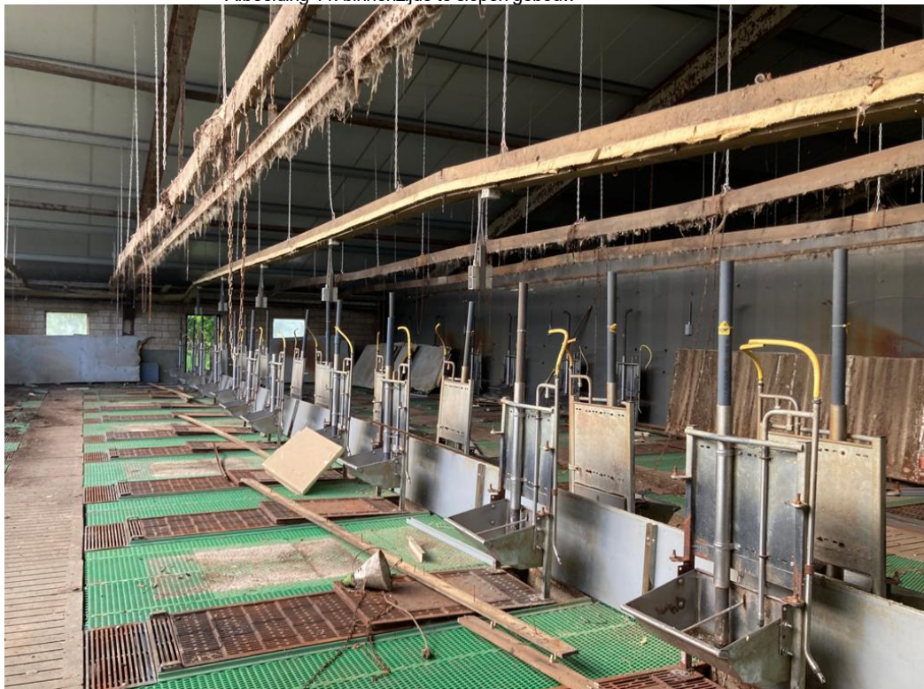
• Afbeelding 11: binnenzijde te slopen gebouw
