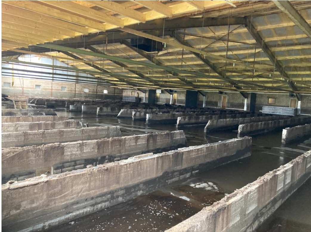
• Afbeelding 6: binnenzijde te slopen gebouw (reeds gestript)
