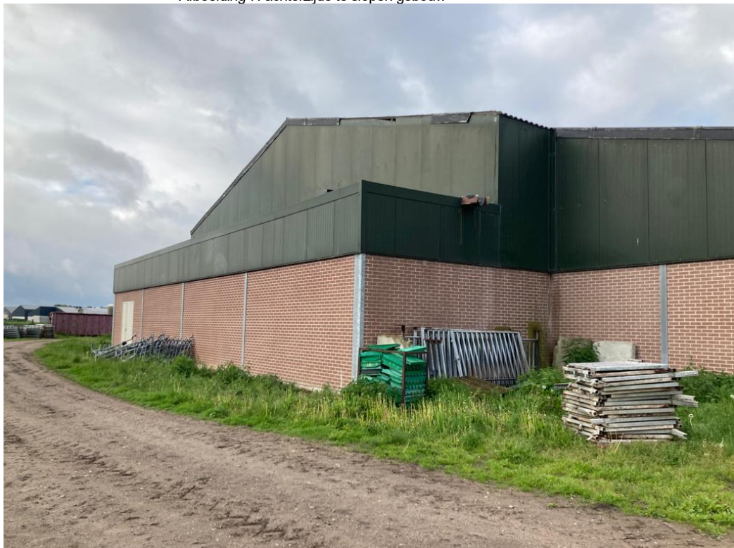
• Afbeelding 7: achterzijde te slopen gebouw
