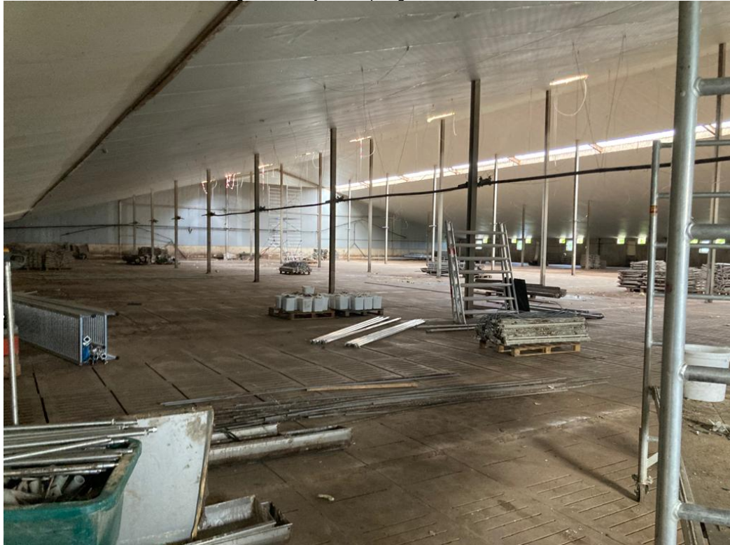
• Afbeelding 8: binnenzijde te slopen gebouw
