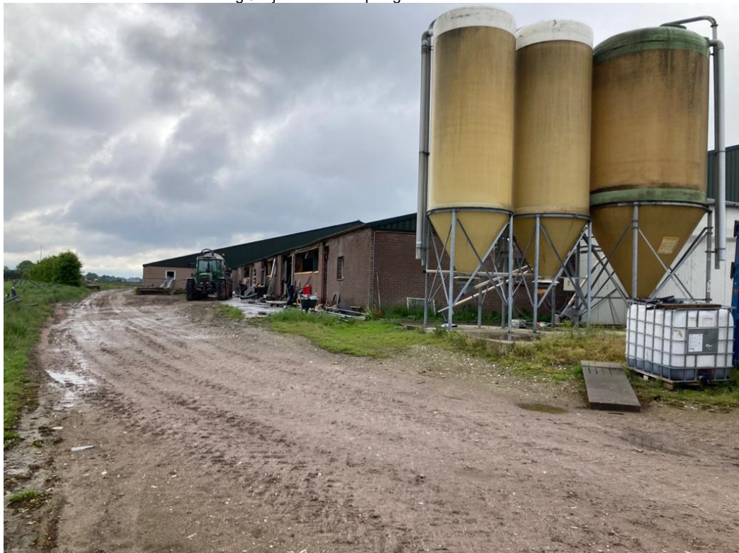
• Afbeelding 3: zij aanzicht te slopen gebouwen
