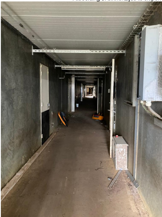
• Afbeelding 9: binnenzijde te slopen gebouw
