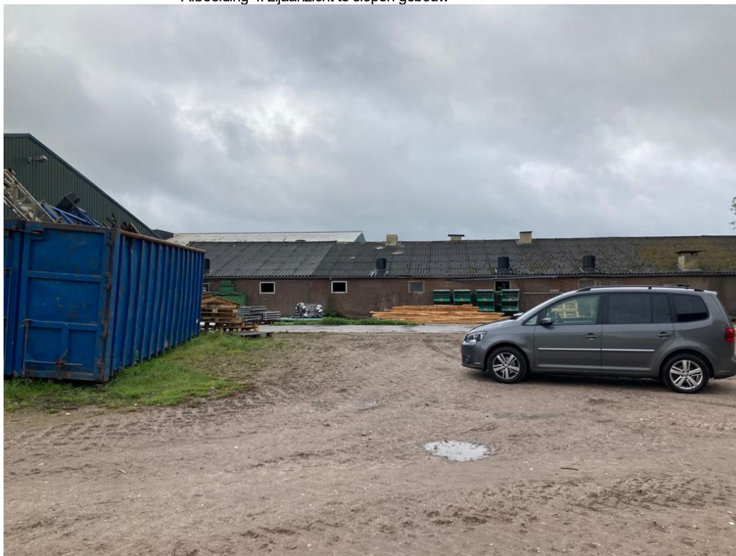
• Afbeelding 4: zij aanzicht te slopen gebouw
