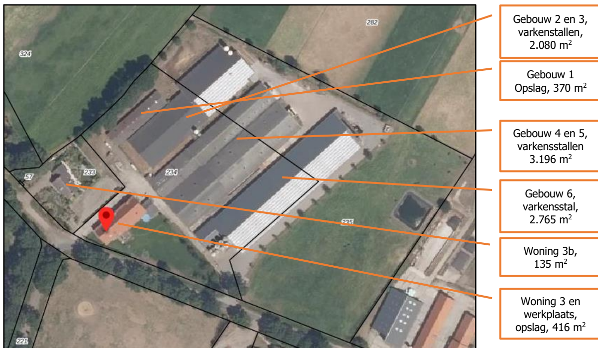
Afbeelding 2: overzicht aanwezige bebouwing (bron: www.ruimtelijkeplannen.nl )
