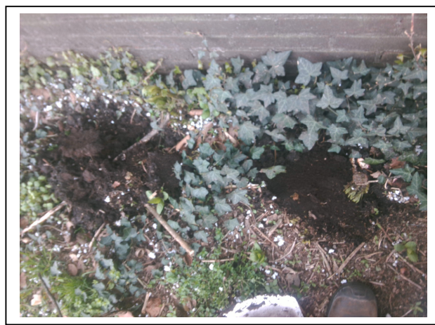
Foto 6. Asbestinspectiegat met opgegraven materiaal Sp 3-2
