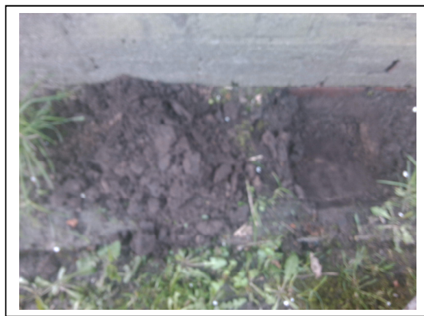
Foto 4. Asbestinspectiegat met opgegraven materiaal Sp2-2
