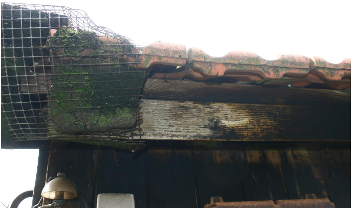
Figuur 4.2.3. De dakpannen sluiten nauw aan op de noordelijke houten wand van gebouw 4.
